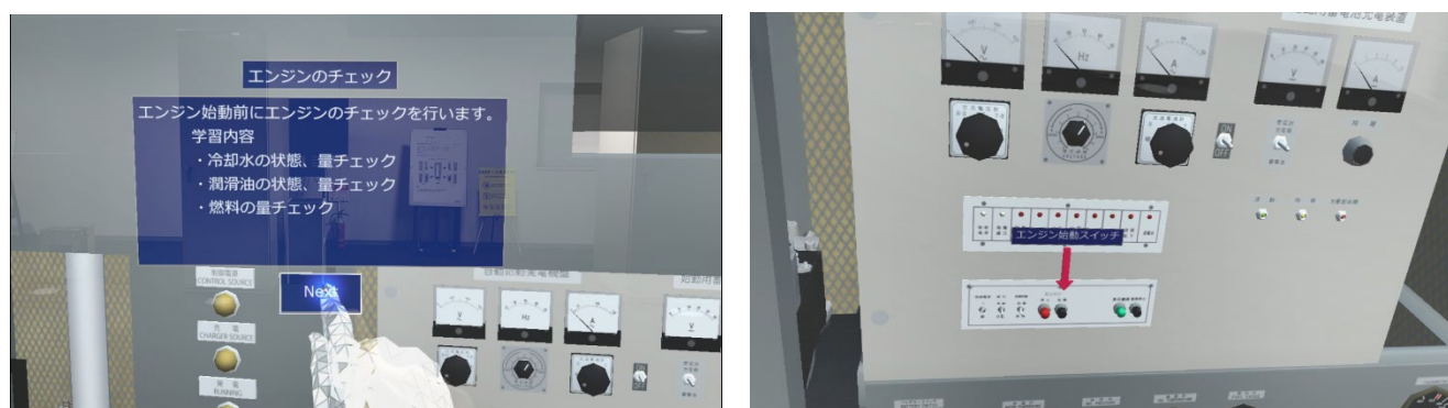
左: 表示されたガイダンスの手順を進める様子 右: 矢印とテキストでメンテナンス箇所を表示 (出典: 明電舎)
