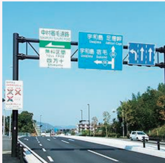
道路標識の施工例
